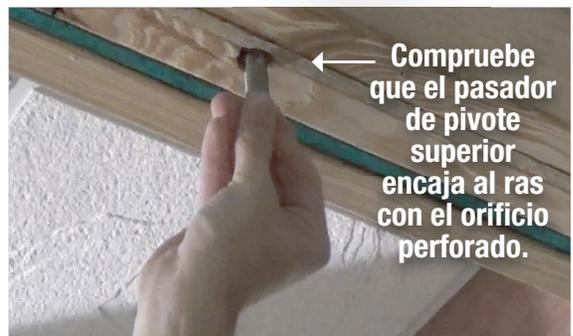
Compruebe que el pasador de pivote superior encaja al ras con el orificio perforado.
