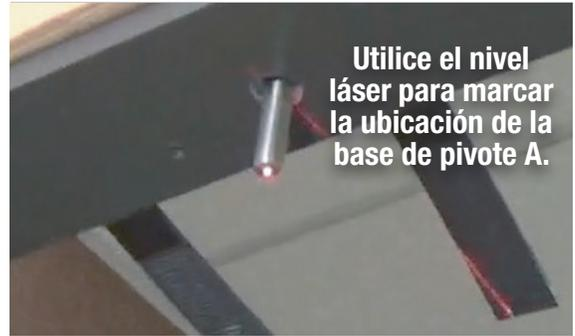
Utilice el nivel láser para marcar la ubicación de la base de pivote A.
