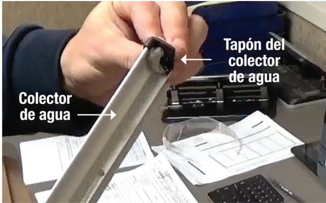
Coloque un cordón de silicona 100% a lo largo de los bordes interiores de los tapones de los colectores de agua. Colóquelos a presión en ambos extremos de los colectores de agua del umbral y del dintel. Alise el exceso de silicona en el punto de unión entre el tapón del colector de agua y el colector de agua para crear un sello hermético.
