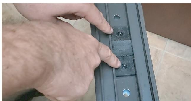
Inserte la tapa del orificio de drenaje en el carril del umbral de forma que cubra los orificios fresados del umbral.
