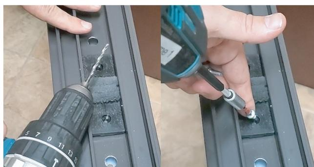
Fije la tapa del orificio de drenaje con tornillos autorroscantes.
