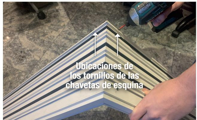
Fije las cuatro chavetas de esquina a cada lado del marco con tornillos. Sumerja los tornillos.
