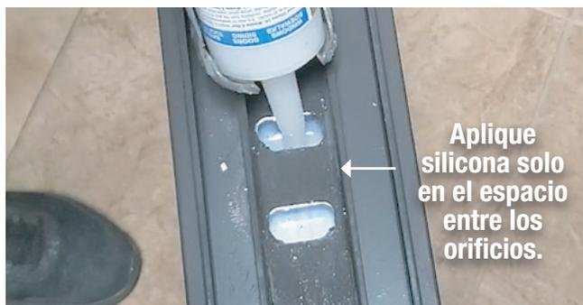
Localice los orificios de drenaje previamente fresados en el carril del umbral y situados en cada interbloqueo del panel y, a continuación, aplique silicona en el espacio entre ambos orificios para crear un sello. Es posible que tenga que dar forma a la silicona con los dedos para crear el sello entre los dos orificios.
